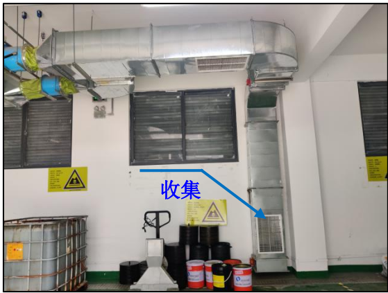
排气筒内部管道
