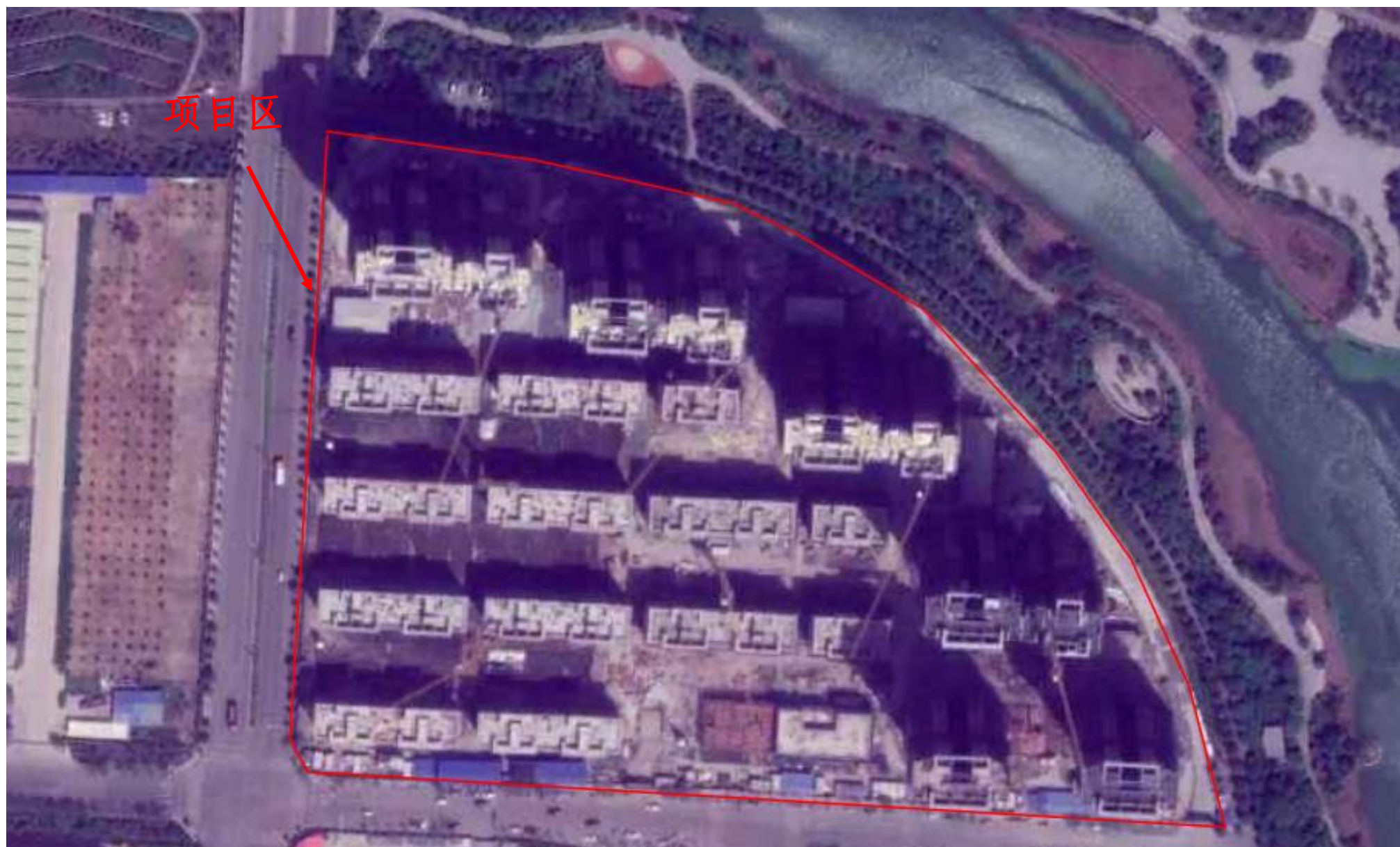
附图 4 项目区施工中影像
